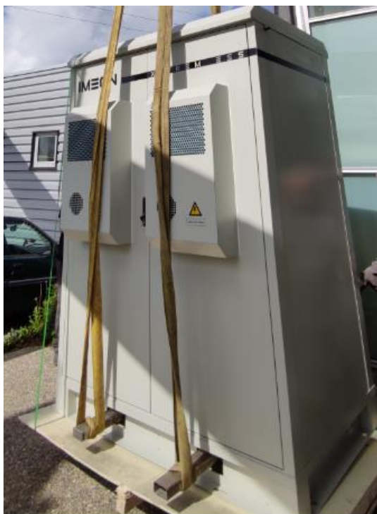
Figure 6 – Manipulation de l'armoire X-HOME / X-TREM (image non contractuelle)
